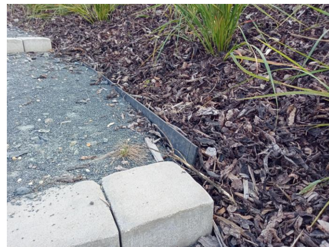
Obrázek 25: Málo kvalitní „hobby“ materiály – plastový obrubník na dětském hřišti Ondřeje Sekory (33/U). Do veřejného prostoru je vhodnější například ocelová obruba.
